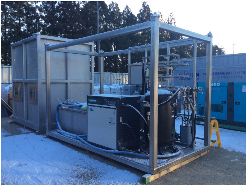
雪の中での脱水システムの1Fへの移動準備 Dewatering System prepared for transport to 1F, with a little snow
